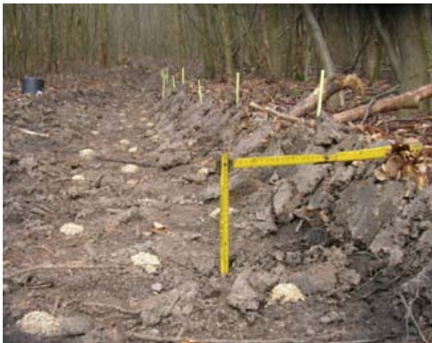
Abb. 2: Versuchsgasse im Wald mit Regenerationsmaßnahme (Branntkalk verfüllt in Stanzlöcher)
