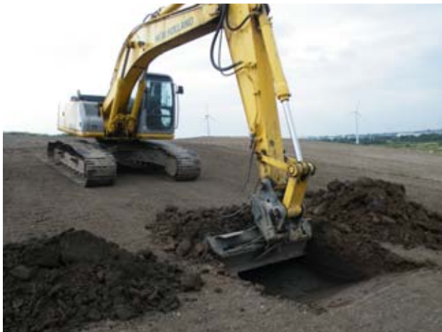
Abb. 1: Aufgrabung eines Bodenprofils auf der Deponie
