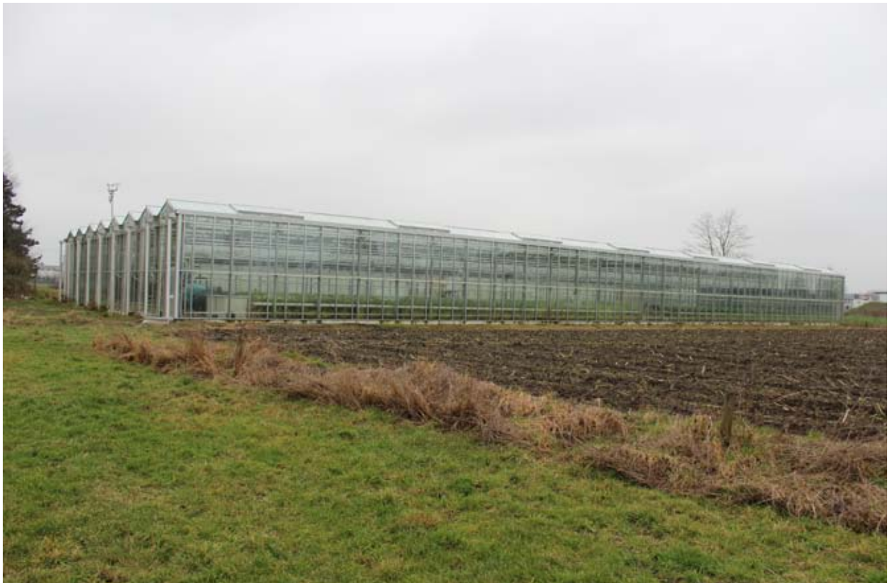
Abb.: Das mit WSG eingedeckte Gewächshaus der Firma Dürbusch
