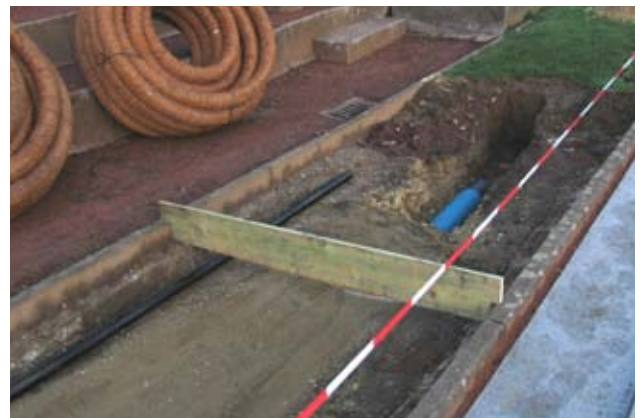
Abb. 2: Bau Finnbahn RWTH Aachen (Entwässerung und Versickerung)
