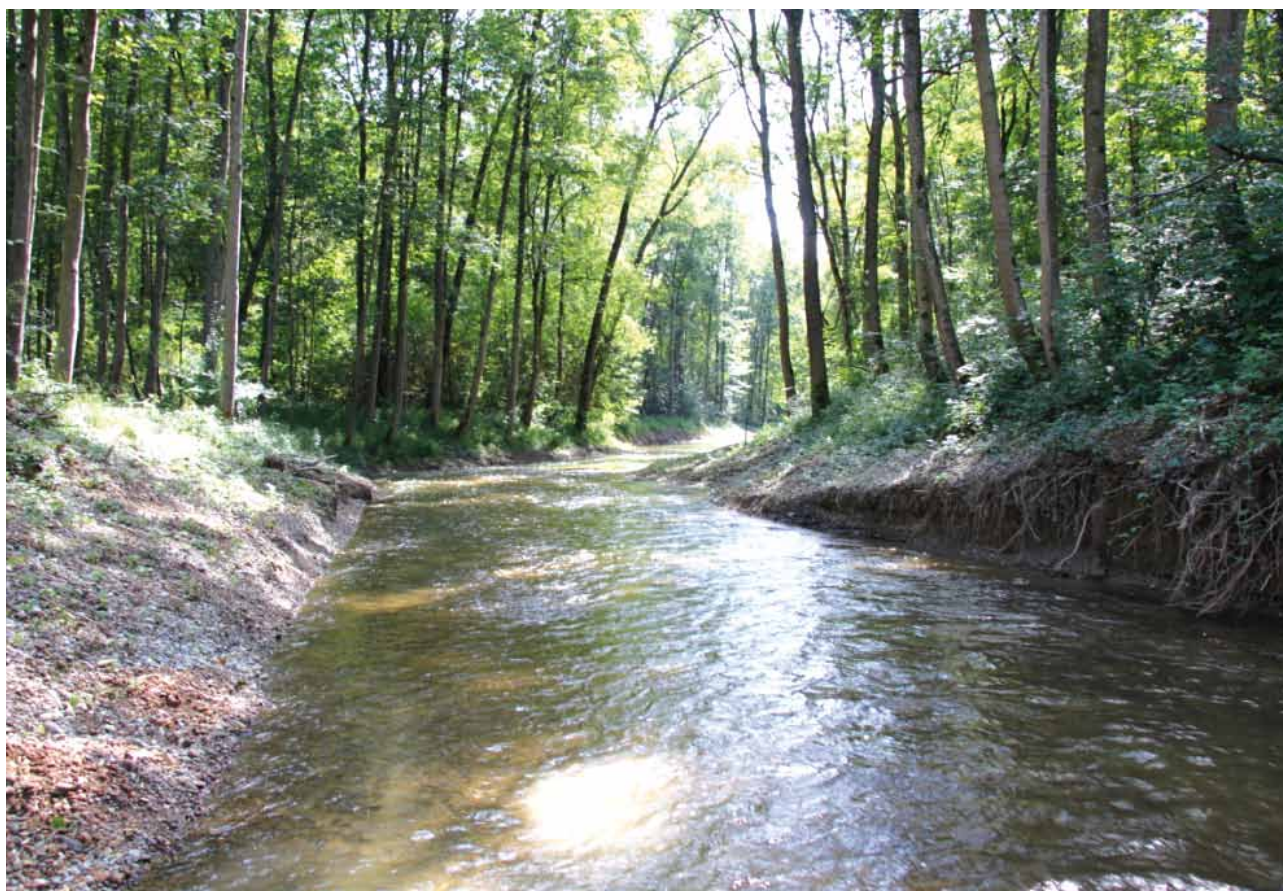
Abb. 2: Umgehungsgerinne in den Donauauen nach der Wassereinleitung
