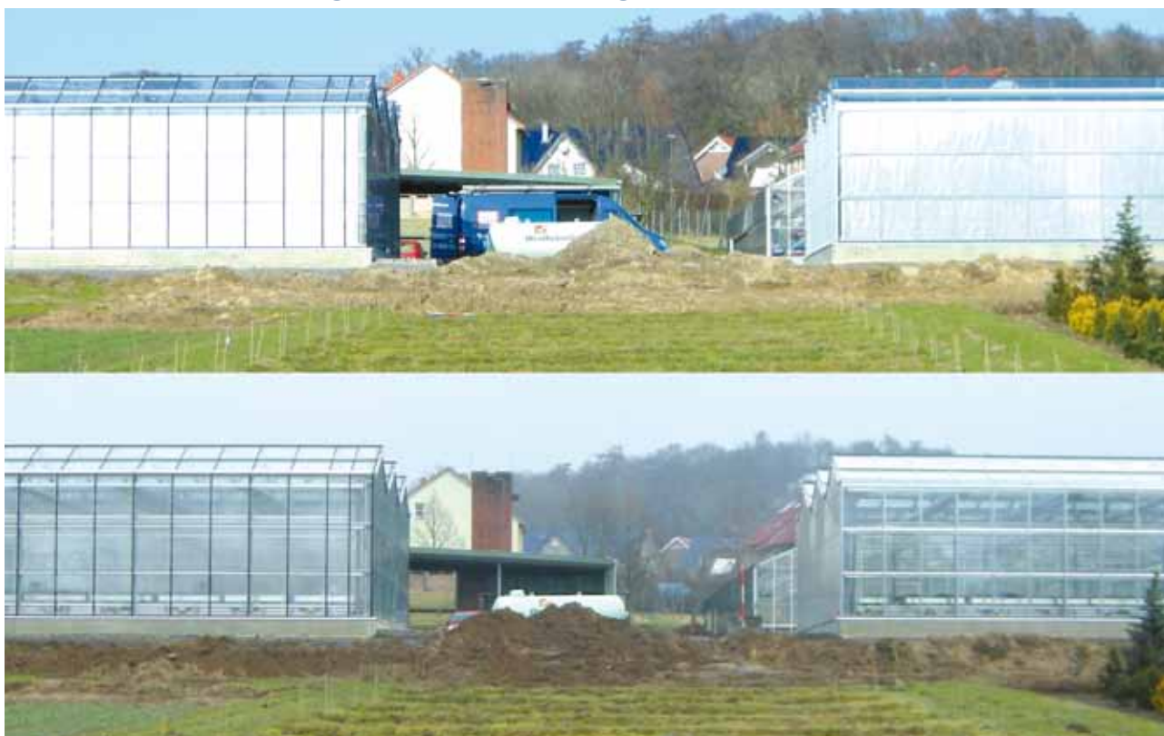
Abb.: Oben links Referenzhaus, oben rechts Haus mit WSG bei sonnigem Frühjahrswetter und geschlossener Schattierung, unten bei trübem Wetter
