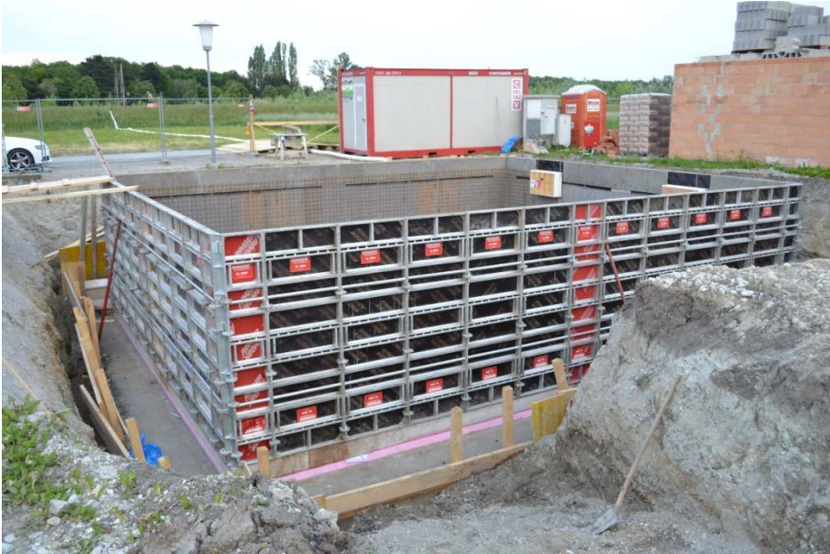
Abbildung 4: Schalungskörper einer Ortbetonwand (Bildquelle: wir-bauen.webnode.at)
