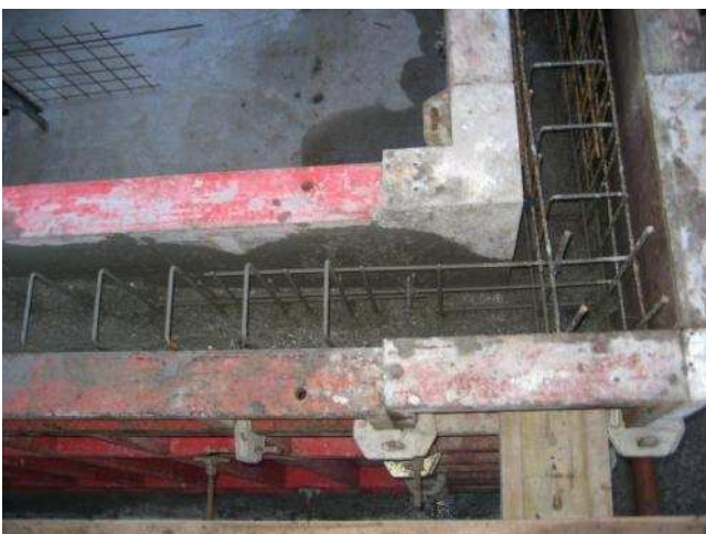
Abbildung 5: Schichtweise eingebrachter Beton (Bildquelle: sautter.com)
